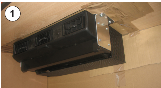
evaporador en techo
