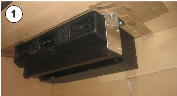
évaporateur au plafond
